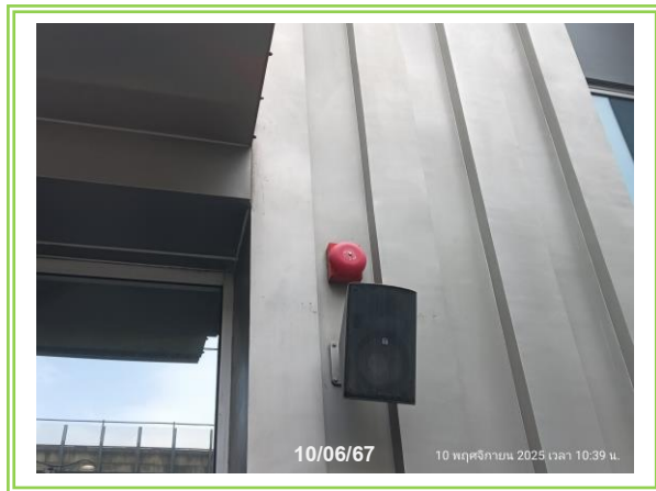
รูปที่ 3-71 กริ่งสัญญาณเตือนภัย
