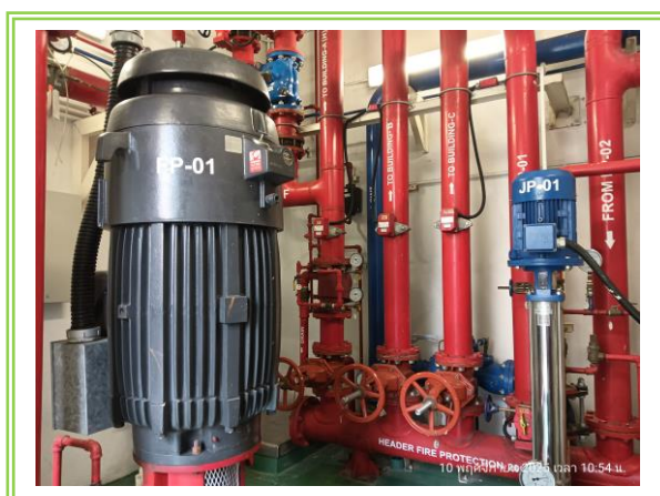
รูปที่ 3-58 เครื่องสูบน้ำดับเพลิง (Fire Pump)
