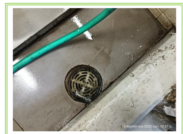
รูปที่ 3-37 ท่อรวบรวมน้ำเสียห้องพักขยะมูลฝอยรวม
