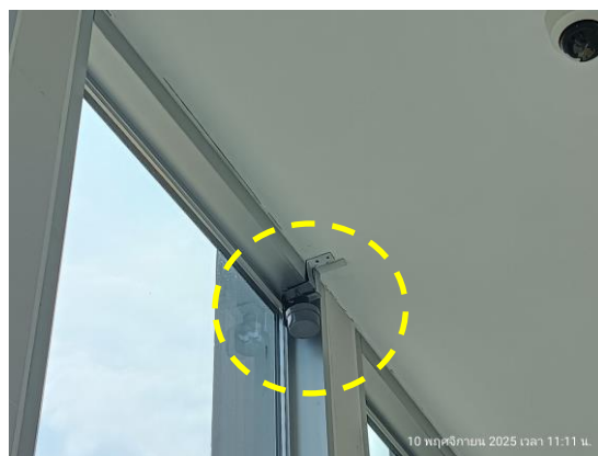
รูปที่ 3-50 ระบบ Light sensor
