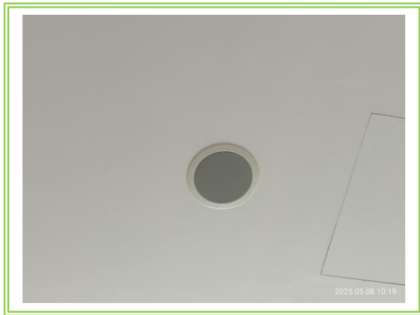
รูปที่ 3-69 ลำโพงแจ้งสัญญาณเตือนอัคคีภัย
