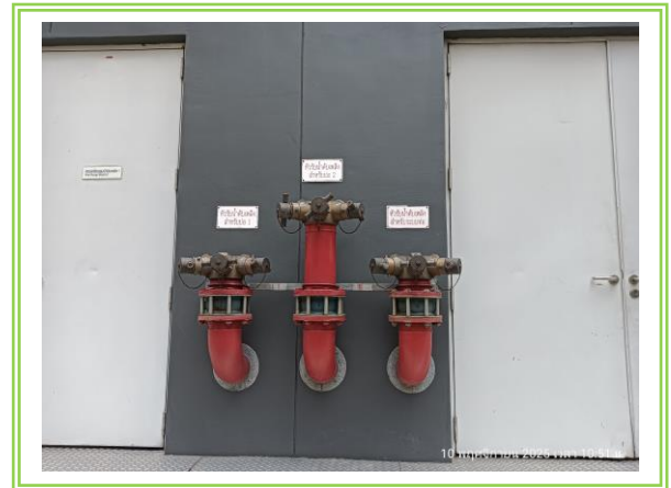
รูปที่ 3-60 หัวรับน้ำดับเพลิงภายนอกอาคาร
